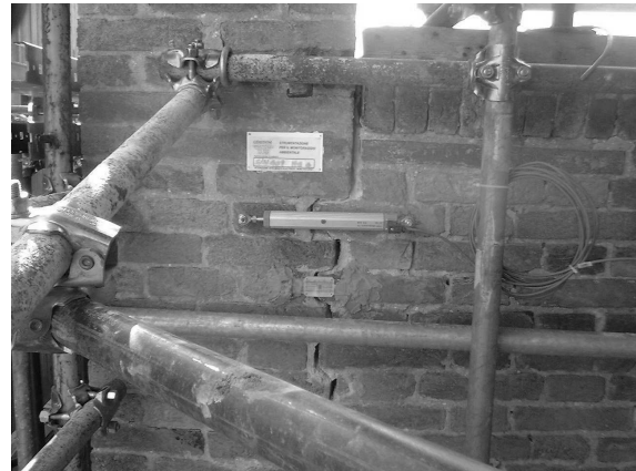
Foto 4. Misuratore di giunto a cavallo di una fessura
