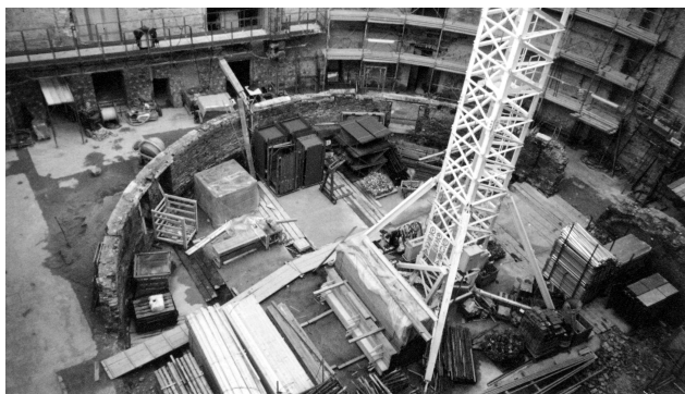
Foto 2 – Vista della Sala Teatrale ad inizio lavori
