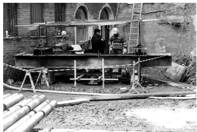
Foto 5 - Prova di carico su un tubfix
